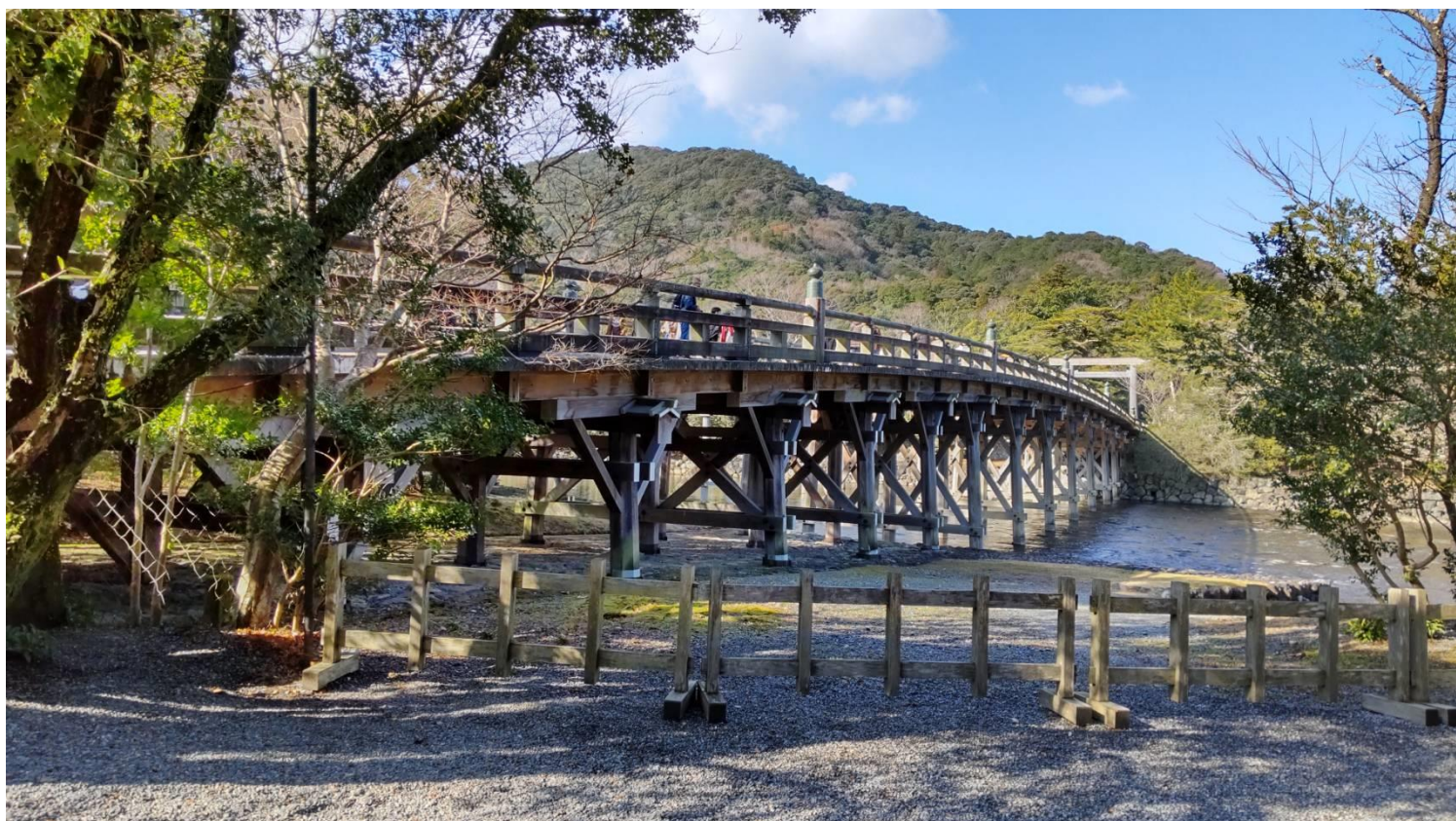
宇治橋の橋脚
